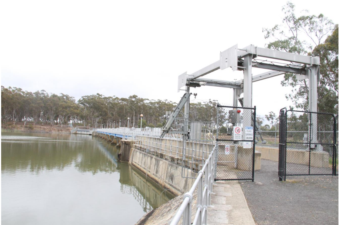
灌区水闸工程
